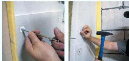
**ВНИМАНИЕ!** Головка винта утапливается в поверхность виброузла не более чем на 1-2 мм!
