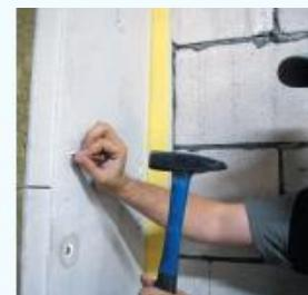
В полученные отверстия вставляются пластмассовые дюбели, в которые предварительно на нескольких витках резьбы, не допуская расширения дюбеля, ввинчивается шуруп с шайбой. После того как дюбель вставлен в просверленное отверстие, его забивают до упора при помощи молотка и завинчивают с подложенной под его головку конусной шайбой.
