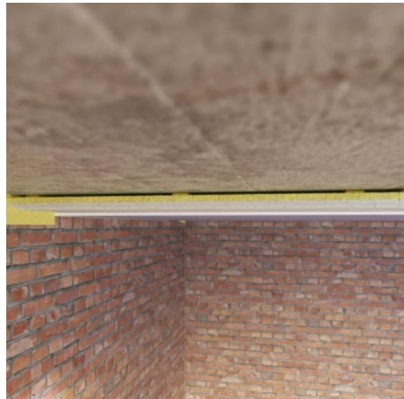
**Площадь: 13 м<sup>2</sup>****Толщина конструкции: 55 мм****ΔRw \* ~ 16–18 дБ**
